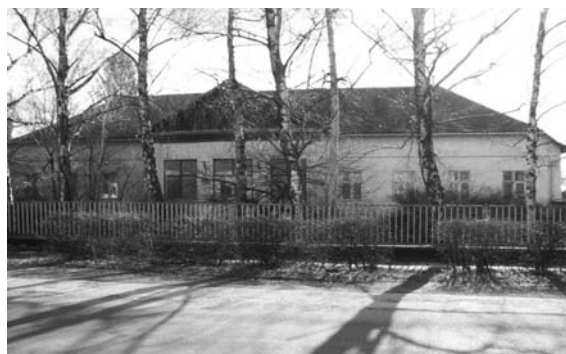
A táti Eggenhofer-kúria: kisajátítás 1952-1953 községháza, 1982-ig nagyközségi tanács. 1990-től rehabilitációs foglalkoztató, gépalkatrészek összeszerelő műhelye. Jelenleg üresen áll.
